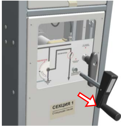
Рис.6.23. Извлечение рукоятки управления разъединителем
