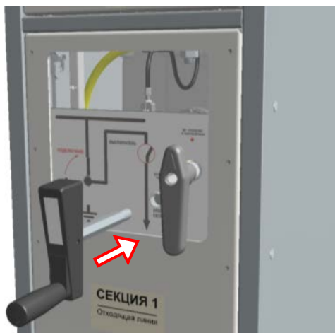
Рис.6.21. Установка рукоятки управления разъединителем
