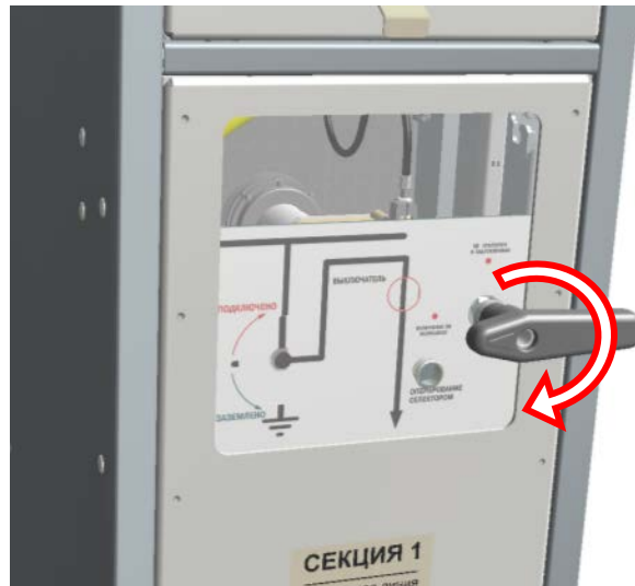
Рис.6.18. Аварийное отключение фидера
